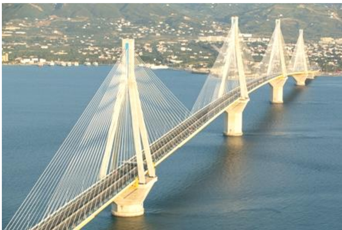
Γέφυρα Ρίου – Αντιρρίου
